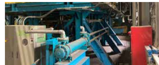
既存設備への振動対策の実施
