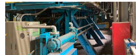
既存設備への振動対策の実施
