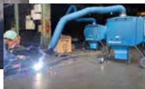
工場内の粉塵対策の実施
