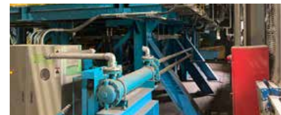
既存設備への振動対策の実施
